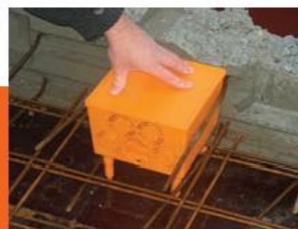
4/ Positionner la boîte sur la dalle
