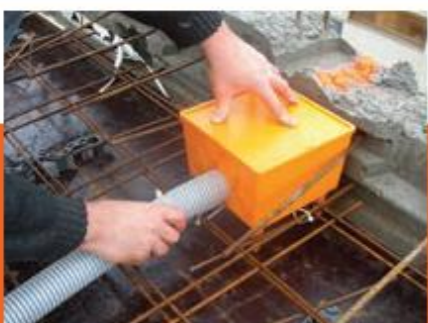
6/ Introduire le(s) fourreau(x) bouchonné(s) dans la boîte
