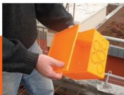
1/ Assembler le couvercle sur la boîte
