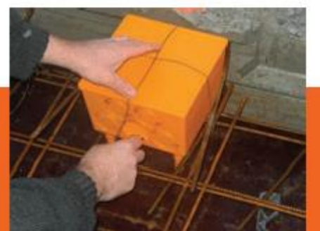
5/ Accrocher la boîte au treillis à l'aide de fil de fer ou liens plastiques
