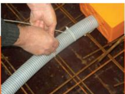
7/ Accrocher le(s) fourreau(x) au treillis
