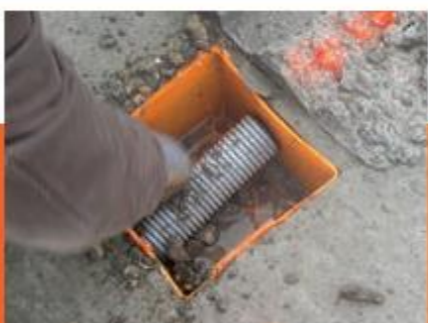
9/ Ouvrir le couvercle pour libérer le(s) fourreau(x)
